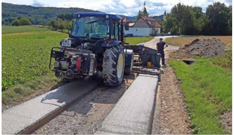
Mehrere Betonspurwege wurden im Sommer bereits fertiggestellt.
