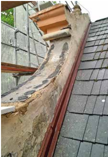
Nach dem Kirchturm geht es bei der Fassade mit der Sanierung weiter.
