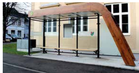
Das neue Buswartehäuschen vor der Europa-Mittelschule.
