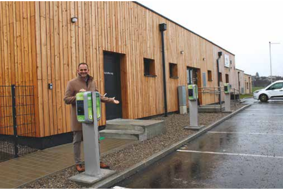
Mit den neuen Elektrozapfsäulen bei der Naturbadeanlage gibt es nun bereits sechs Ladestellen der Gemeinde.
